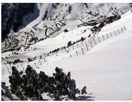
Fig 4: Barreres GL en la zona de generació de l'allau amb l'objectiu de protegir una carretera de l'efecte dels allaus.
