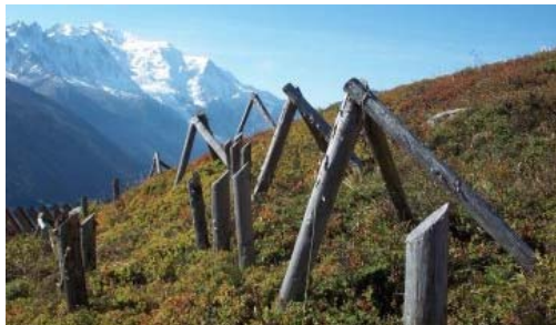
Fig 2: Proteccions situades en la zona de generació de l'allau amb l'objectiu d'incrementar la rugositat del terreny.
