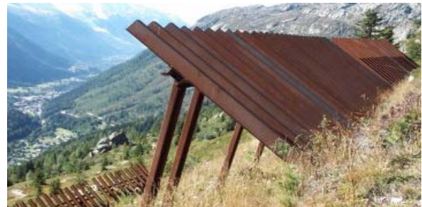
Fig 3: Proteccions metàl·liques rígides en la zona de generació de l'allau amb l'objectiu de sostenir el mantell nival.
