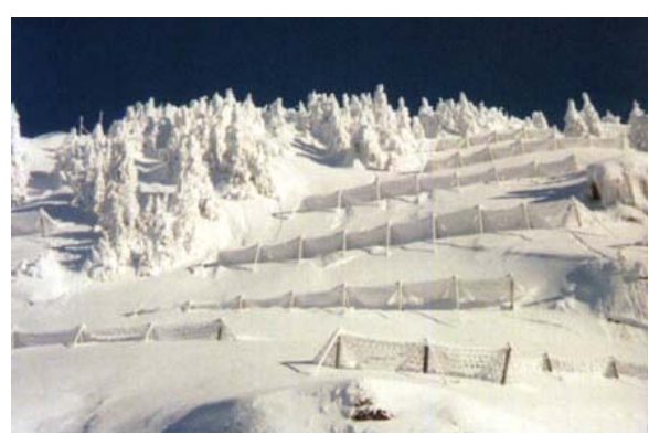
Fig 4: Barreres GL en la zona de generació de l'allau amb l'objectiu de protegir una carretera de l'efecte dels allaus.
