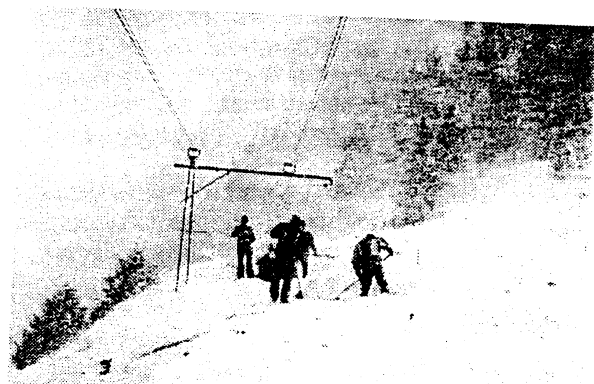
Fig. 5.- Una allau va colgar la via del cremallera de Núria uns 50 m, durant l'hivern l'accés amb cremallera va estar interromput més de 15 dies per diverses allaus. Font: C. Garcia.
