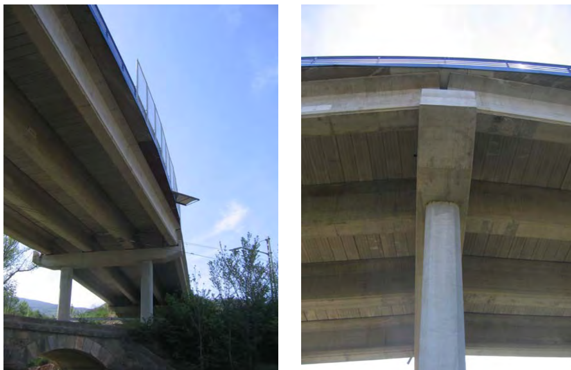
Figura 11. Columnas sobre pórticos y soportando cargas de hormigón armado.
