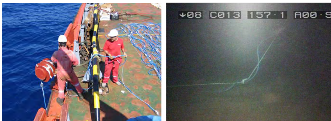
Figura 4: Izquierda: Lanzamiento de los cables. Derecha: Imagen tomada por el robot submarino de los cables cayendo sobre el fondo marino.
