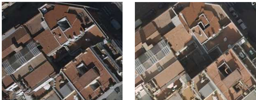
Figura 10: Incongruencias en patios, cajas de ascensor y claraboyas
