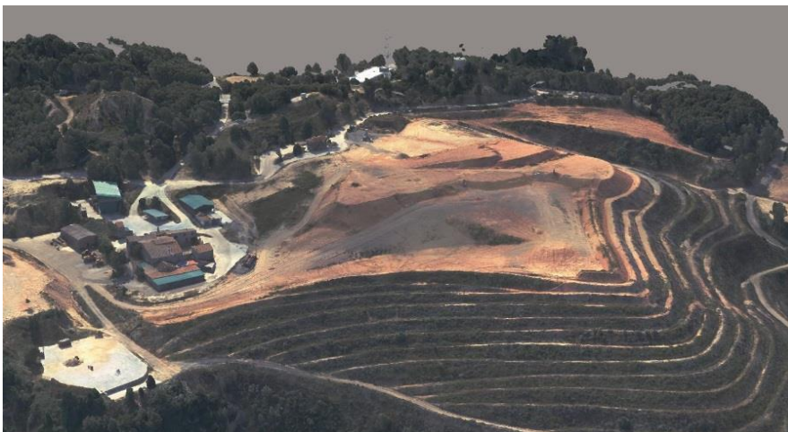
Abocador de Can Carreres (Rubí).
