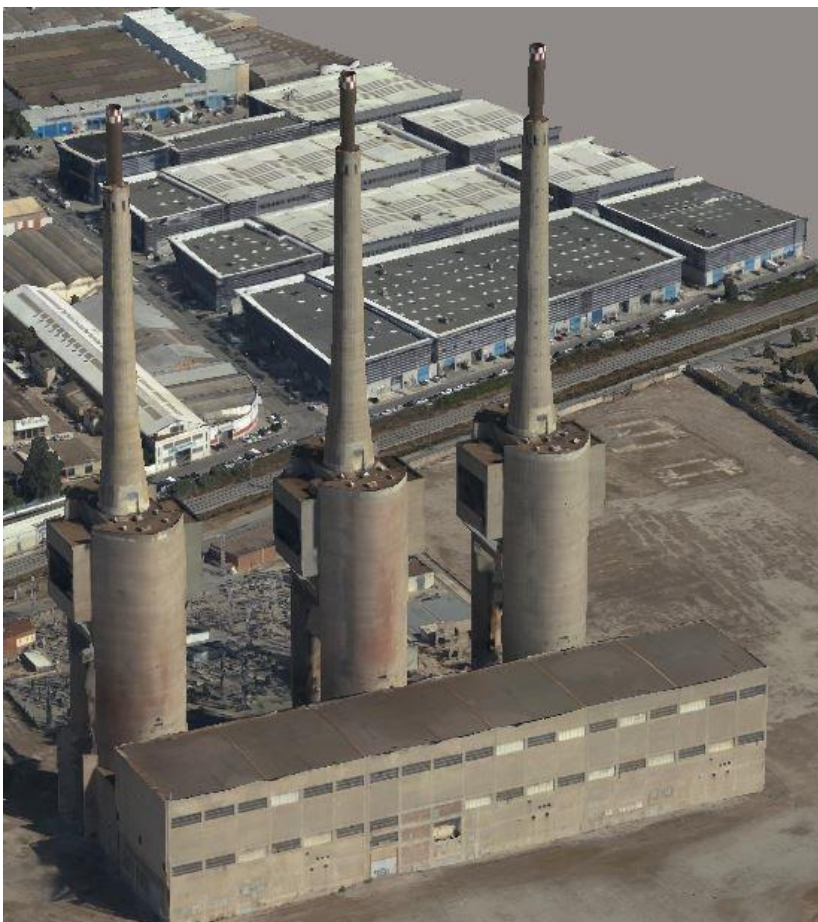
Exemple de la generació d'edificis significatius en una subescena de la Ortofoto3D de Sant Adrià del Besòs.
