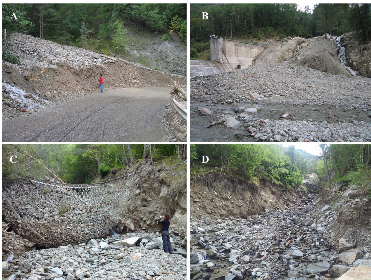
Figura 2. Imágenes de los efectos de las avenidas en Portainé. A) depósito de septiembre de 2008 en la intersección del barranco de Reguerals y la carretera (1465 m s.n.m.). B) depósito de septiembre de 2008 en la confluencia del río de Santa Magdalena con destrucción de la aleta de la presa. C) socavación en una barrera después del evento de agosto de 2010 en el barranco de Portainé (1350 m s.n.m.). D) erosión en el barranco de Portainé (1380 m s.n.m.) en agosto de 2013.
