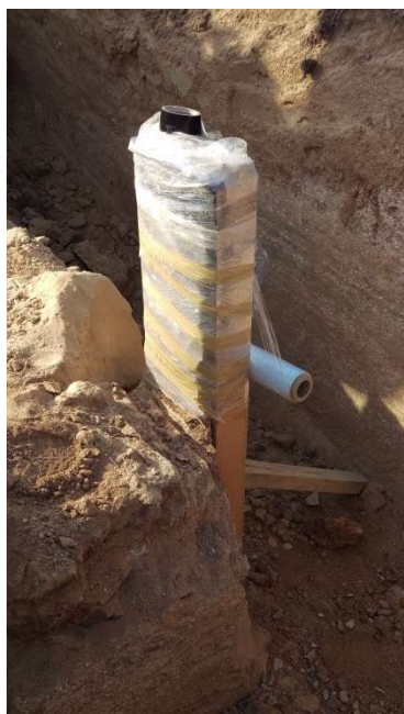
Excavació del Mònolit
