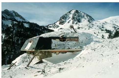
Allau de neu recent que afecta bosc i edificacions
