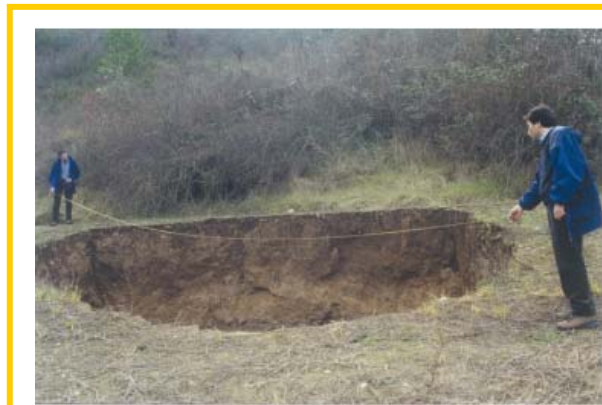
Colapso en una àrea de la zona potàssica
