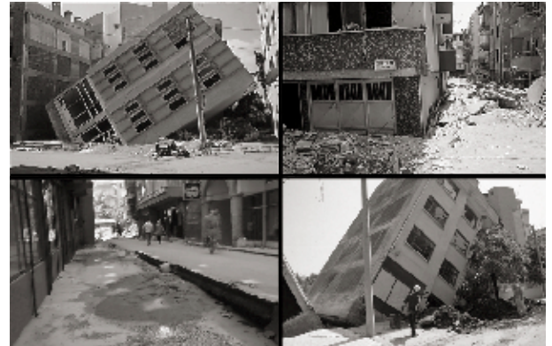
Figura 6. Efectes de la líquefacció del terreny sobre alguns edificis, observats durant el sisme de Kocaeli de 1999 (Roca et al., 2006).
