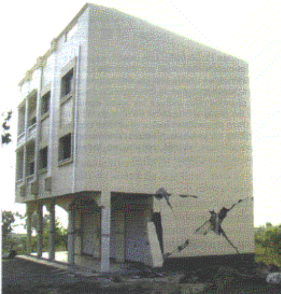
Figura 4. Edificio reparado en Ajdir, con nuevos pilares más gruesos. / PÉTER MURPHY
