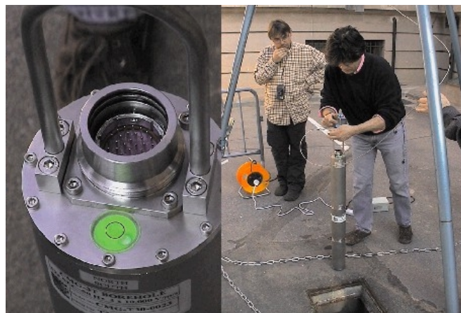
Figura 1. Imagen de la instalación del sensor en el pozo ( Picture of borehole sensor instalation)
