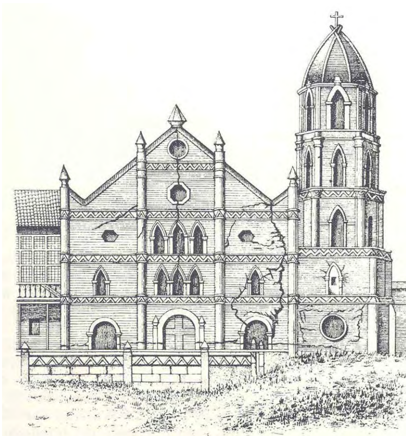
Figura 2. Efectos del terremoto de 1880 en la Iglesia de San Jacinto en Pangasinan (Filipinas). (En Cerero, 1890).
