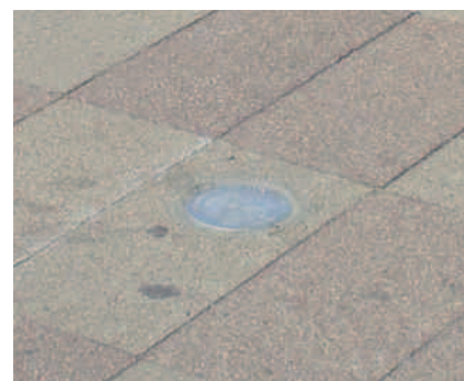
Vèrtex geodèsic ubicat segons la nova tècnica GPS en l'àmbit de la geodèsia, en la qual no cal la visibilitat entre els vèrtexs.
