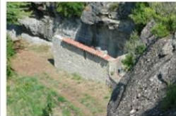
9. Vista del cobert des de sobre
