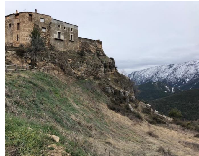
Fig. Blocs caiguts i moviments de vessant a Sant Esteve de la Sarga
