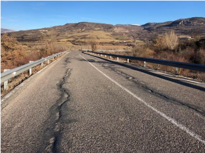
Reconstrucció de carreteres, Guàrdia de Tremp:
