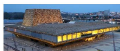
Edifici del Palau de Congressos de Lleida (5600 m 2 )
