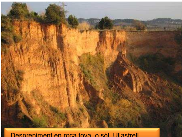
Despreniment en roca tova o sòl, Ullastrell
