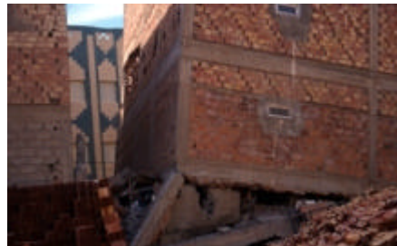
Photos 8 et 9. Deux vues du collapsus d'un bâtiment où une mesure de bruit sismique fut effectuée (degré de dégâts 4-5). Situation sur la figure 3.
