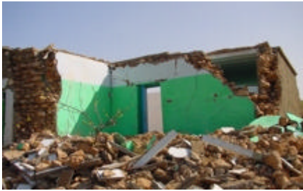
Photos 19 et 20. Exemple de dégâts de degré 5 en des constructions de type A. Situation sur la figure 3.
