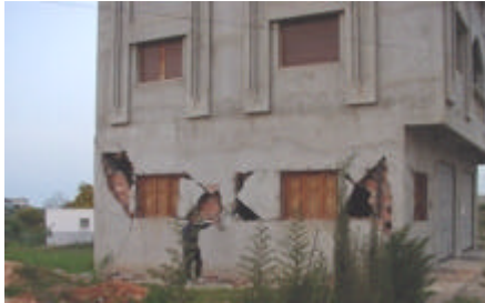
Photos 14 et 15. Bâtiment à piliers écrasés. Détail des dégâts. L'intensité semble être supérieure au degré VIII. Situation sur la figure 3.
