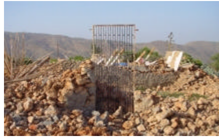
Photos 19 et 20. Exemple de dégâts de degré 5 en des constructions de type A. Situation sur la figure 3.
