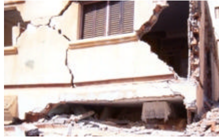
Photos 10 et 11. Deux vues du collapsus d'un autre bâtiment où une mesure de bruit sismique fut également effectuée (degré de dégâts 4-5). Situation sur la figure 3.
