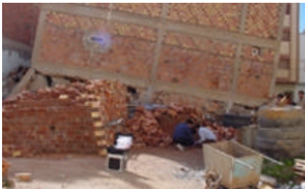
Photos 8 et 9. Deux vues du collapsus d'un bâtiment où une mesure de bruit sismique fut effectuée (degré de dégâts 4-5). Situation sur la figure 3.
