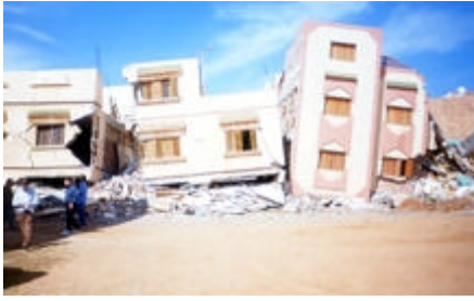
Photos 10 et 11. Deux vues du collapsus d'un autre bâtiment où une mesure de bruit sismique fut également effectuée (degré de dégâts 4-5). Situation sur la figure 3.
