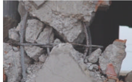
Photos 14 et 15. Bâtiment à piliers écrasés. Détail des dégâts. L'intensité semble être supérieure au degré VIII. Situation sur la figure 3.
