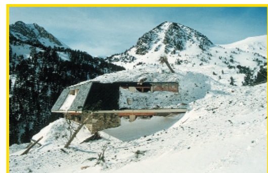
Allau de neu recent que afecta bosc i edificacions.
