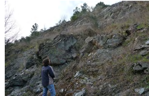
Caigudes de blocs (materials paleozoics fortament deformats i fracturats) en talussos de la variant de Sant Daniel
