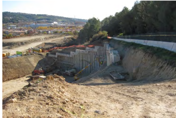
L'alteració de les margues eocenes comporten la construcció d'estructures de retenció robustes per prevenir esllavissades
